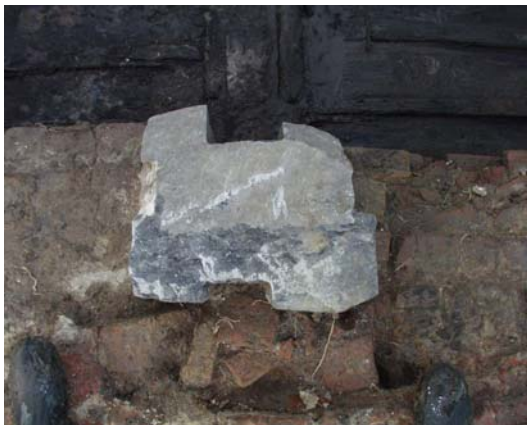
Afb.15 Schotbalkspanning F27 met aan de niet-functionele zijden uitsparingen voor het metselwerk. (foto BAM)
