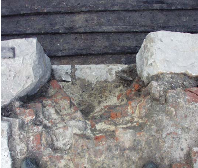
Afb. 11. Op de plek waar een natuurstenen blok verdwenen is, is de puntige vorm van het blok goed te herkennen.
