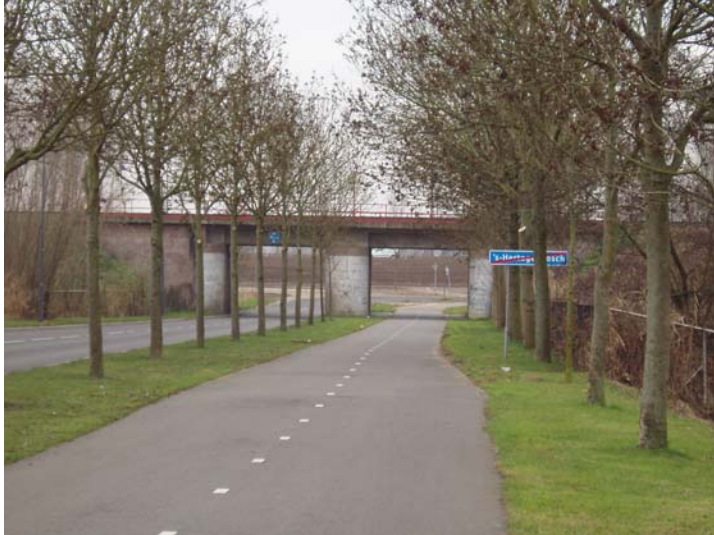
Afb.5 De voormalige sluis uit 1870 onder de spoorlijn naar Utrecht, nu verkeerstunnel. Gefotografeerd naar het westen (foto: BAM)
