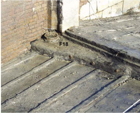
Afb. 14 Detail komplaat F18 met keuspot (foto BAM)
