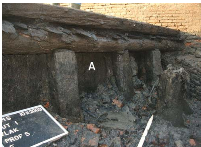
Afb.19 Palenfundering onder F8 met kwelscherm (A). (foto BAM)
